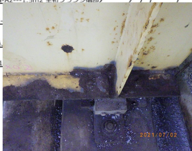
21-0591 発錆、断面減少、断面欠損-A2---1.5m2 主桁フランジ端部
